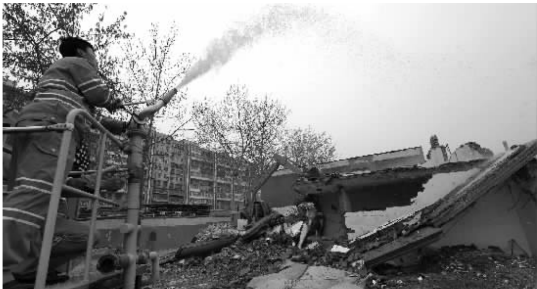
昨天,随着挖掘机的轰鸣声,天景公寓被拆除。
