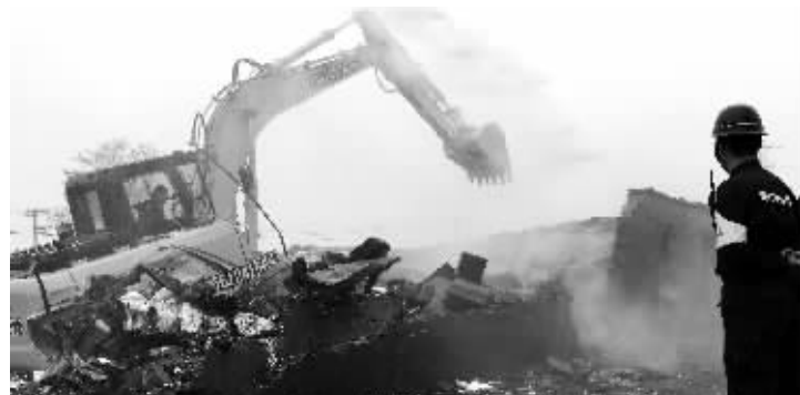
伴随着机器轰鸣,一排违法建设瞬间倒塌。北京晨报记者 李木易/摄
