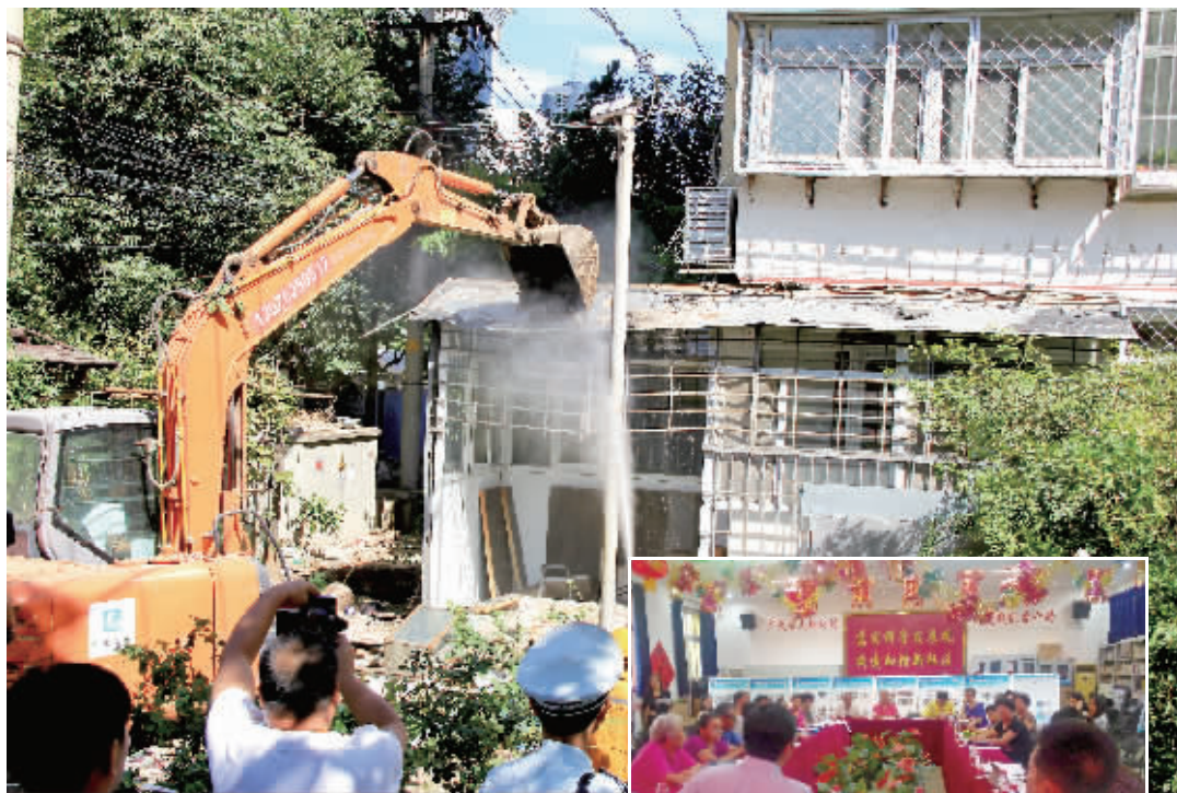
▲老街坊助力拆违。 ▶老街坊共谋社区建设。
