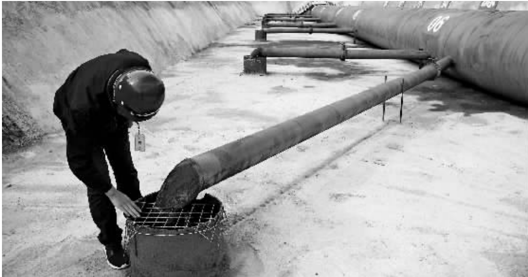
主管线连接的 44 个回灌井口正在回灌地下水。
