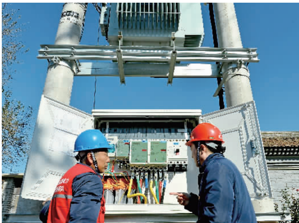
昨天，北京电力公司的工作人员在实施了“煤改电”的顺义区东水泉村使用红外设备对电路进行检测，保障村民安全采暖。
