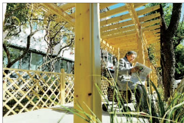
东四胡同“百街千巷”工程中,由违建改造成的绿植廊道即将完工。
