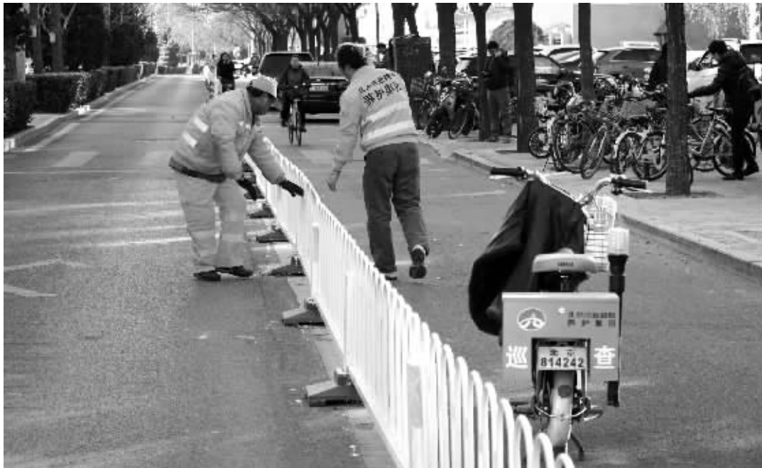
工人师傅正在朝阳门外大街摆放自行车道与机动车道之间的隔离护栏。
