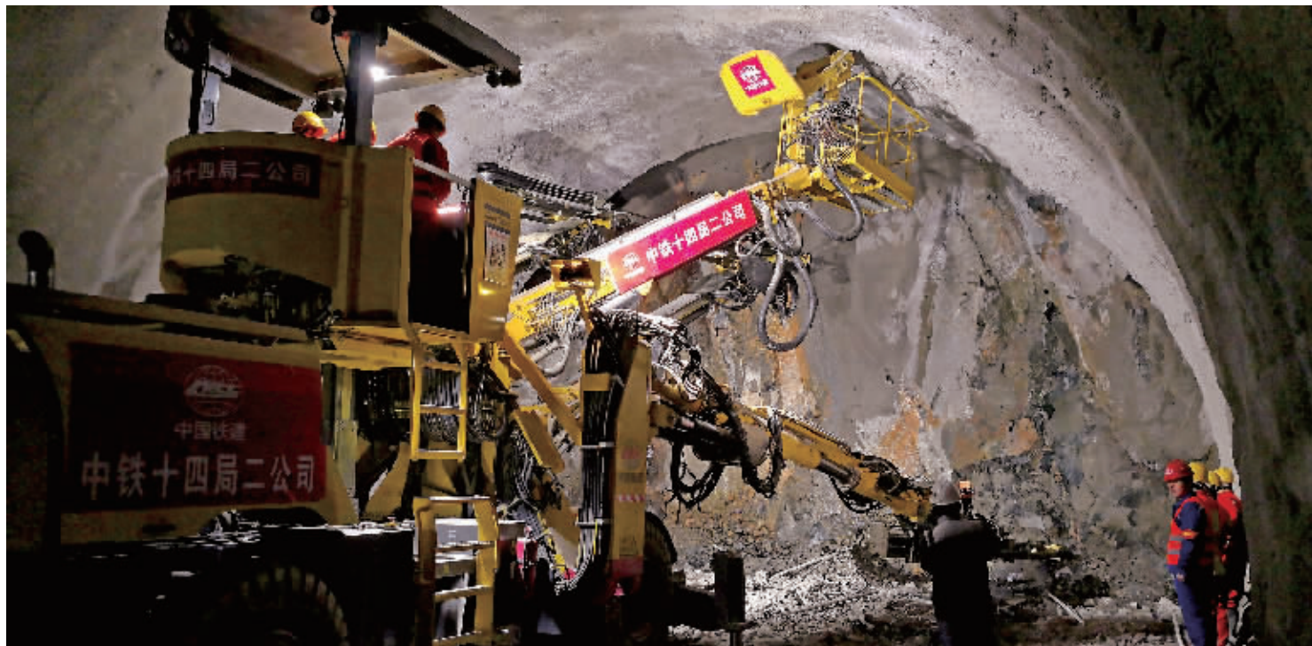
▲延崇高速佛峪口隧道施工中。
