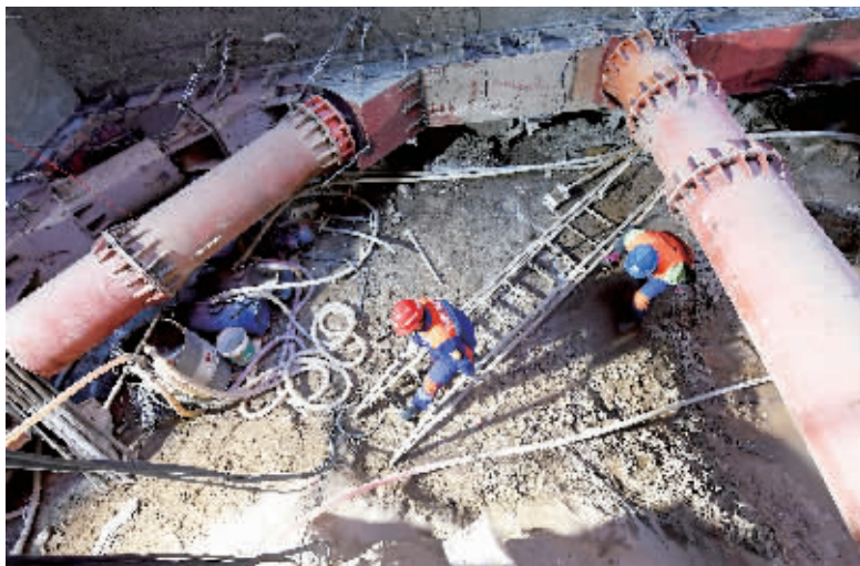
12号线沿线管线情况复杂，光熙门站是其中施工难度最大的站点之一。
