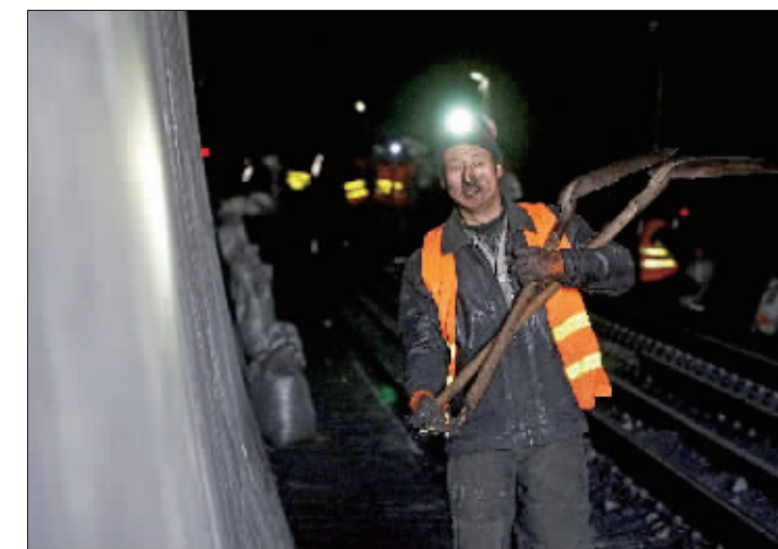
↑隧道里身着防护坎肩的工人正在忙碌着。
