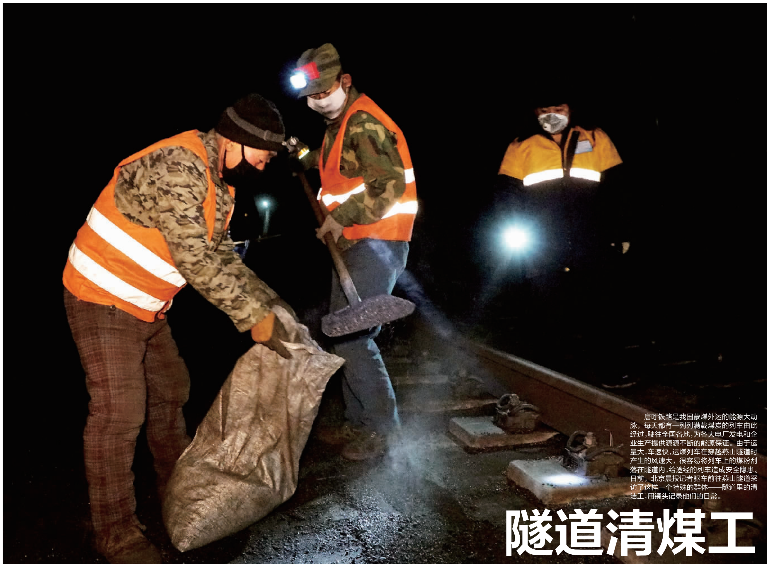
↑燕山隧道内是整体道床，煤烟沉积了厚厚的一层，足有20多厘米。工人们用铁锹将道床里的煤烟装入一个个编织袋，集中堆码在隧道两侧，等轨道车到来后再装车将煤烟运走。
