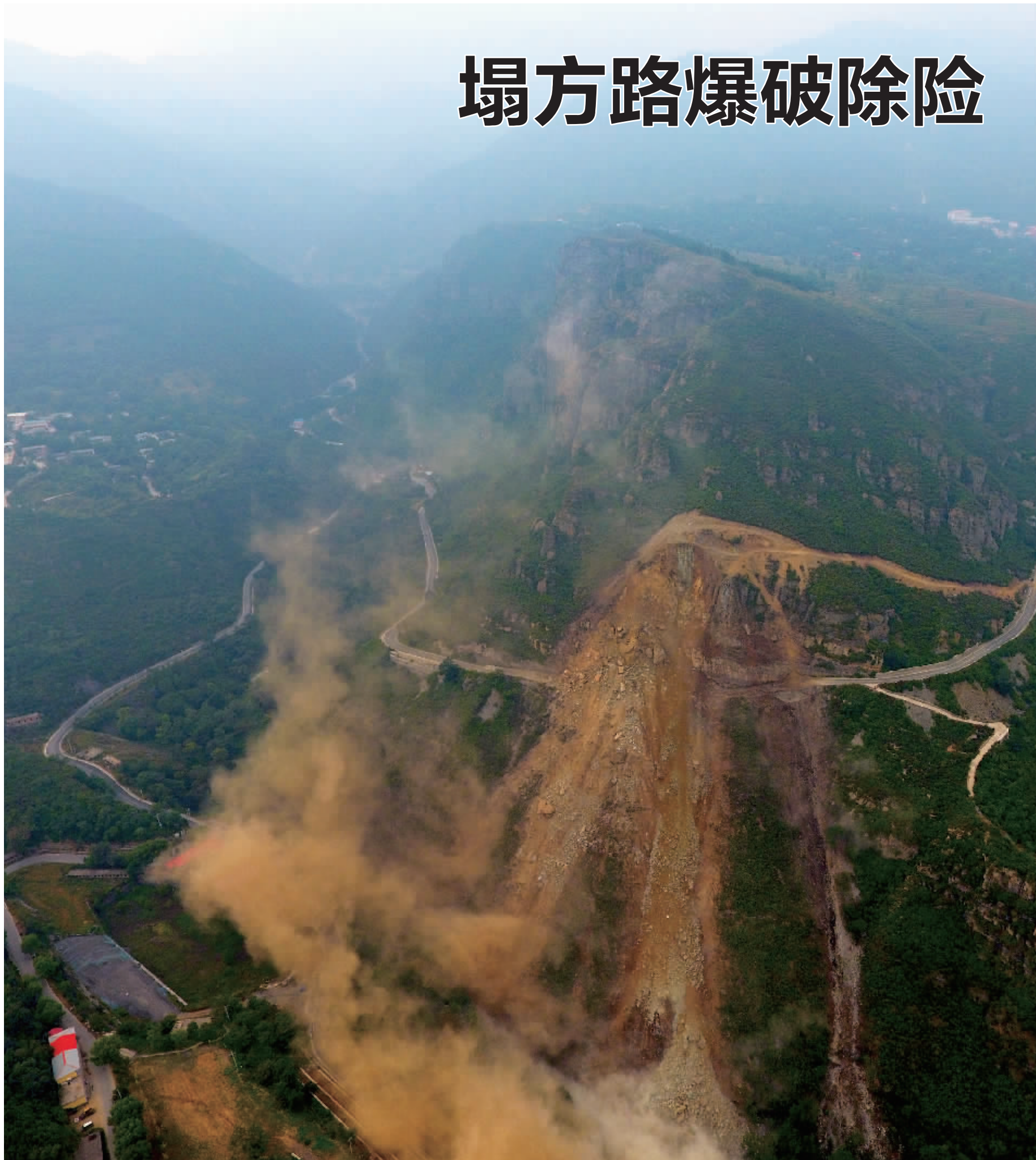
爆破作业现场。实施爆破后,立即开展道路清理作业,修筑损毁的路基。
