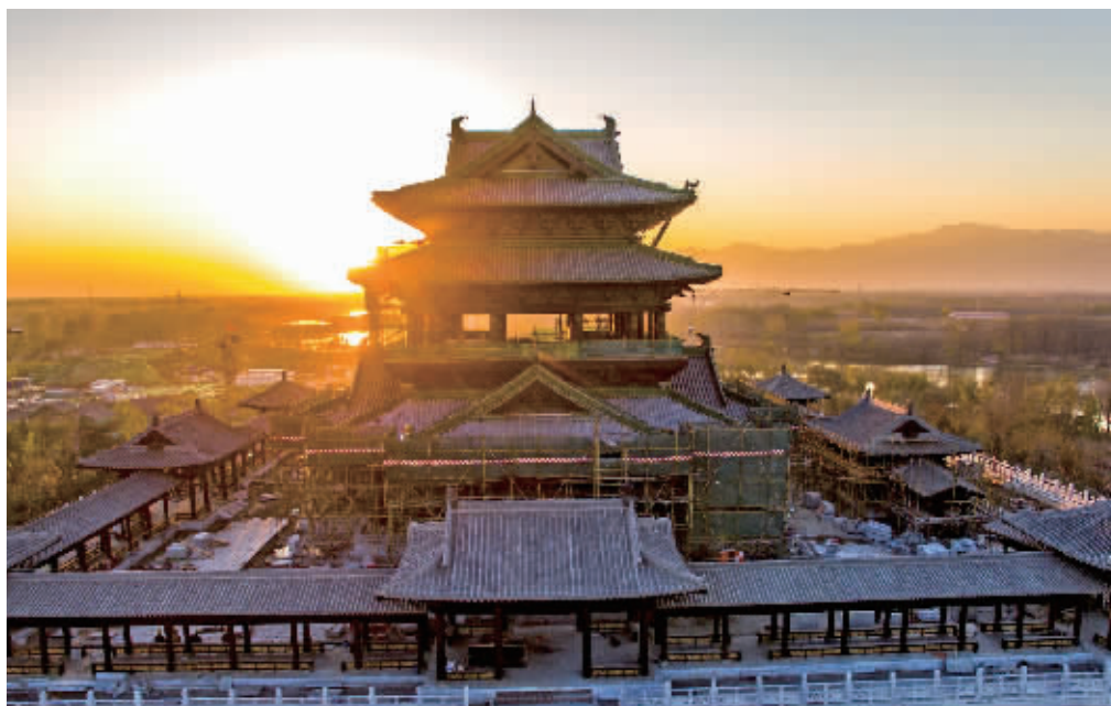
世园会园区在建的永宁阁。
